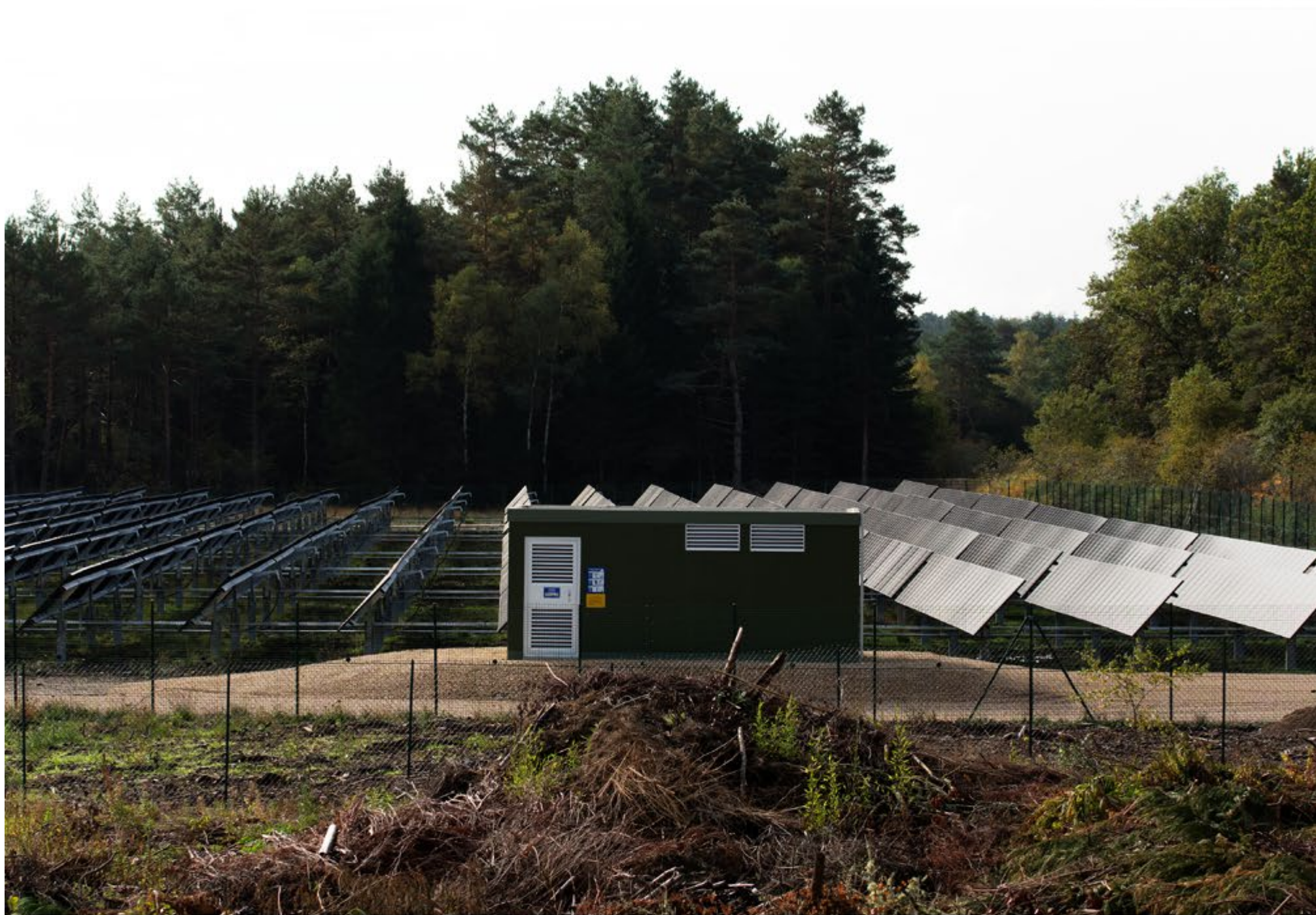
↑ La centrale photovoltaïque du Gros-Chastang, inaugurée le 18 septembre 2015 par François Hollande, s'étale sur 17 hectares. 37 000 modules solaires ont été montés.
